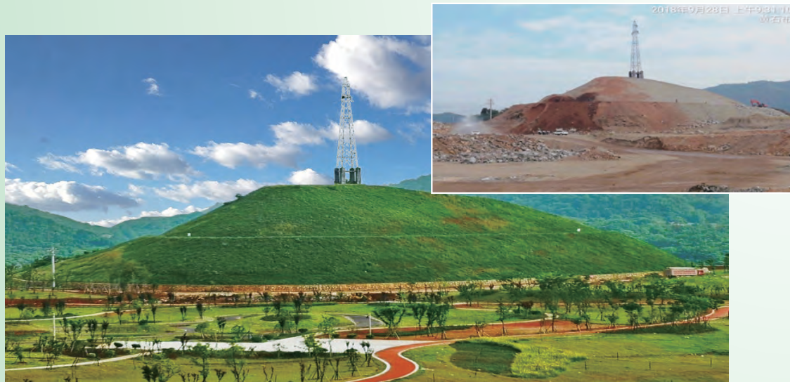
▲湖北黄石铁山—还地桥矿山项目修复前后
