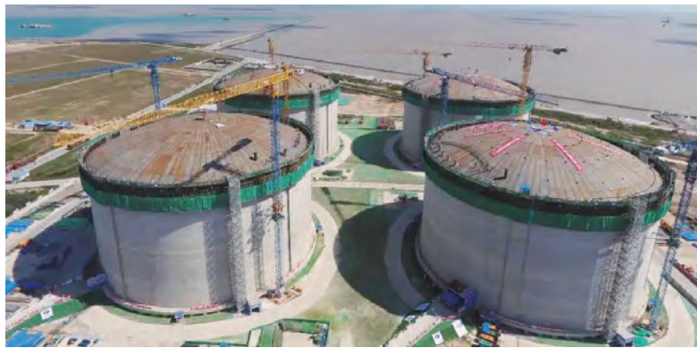
江苏LNG一期工程
