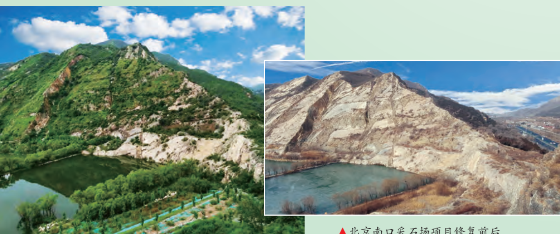
▲北京南口采石场项目修复前后
